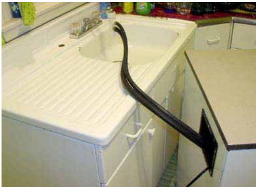
Gambar 3.44 Contoh penyambungan ke kran sumber air
