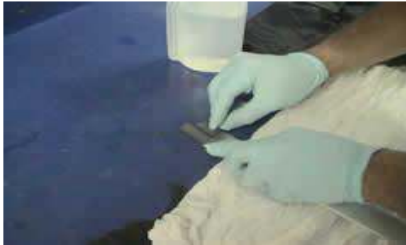
Gb.2.34. Pemotongan dan perapian ujung pita perekat
