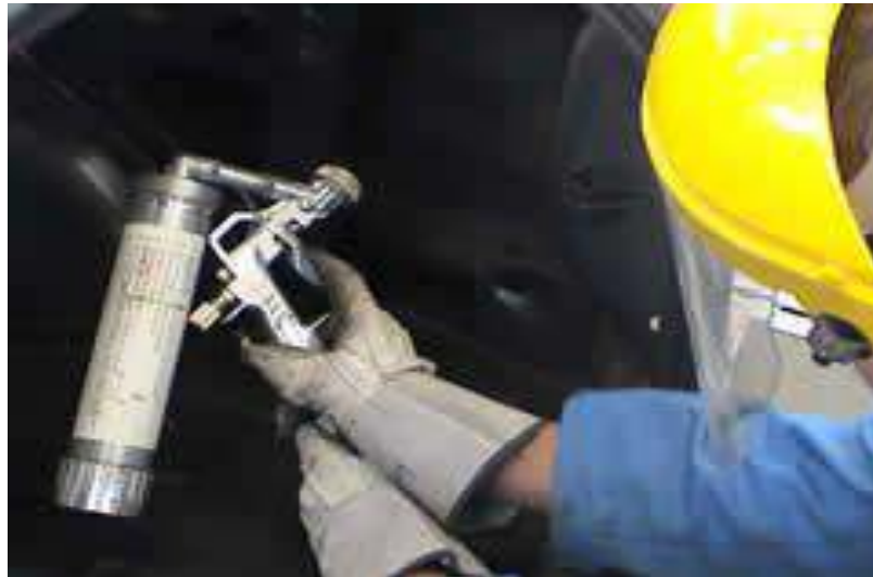
Gb.4.48. Penyemprotan diarahkan pada tempat yang akan dilapisi
