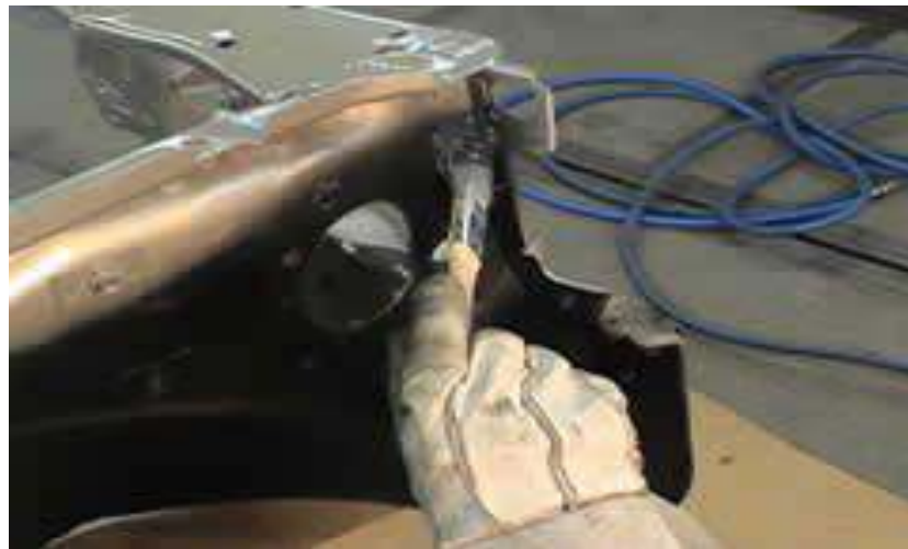
Gb.4.16. Penggunaan kuas untuk melapiskan brush-on sealant
