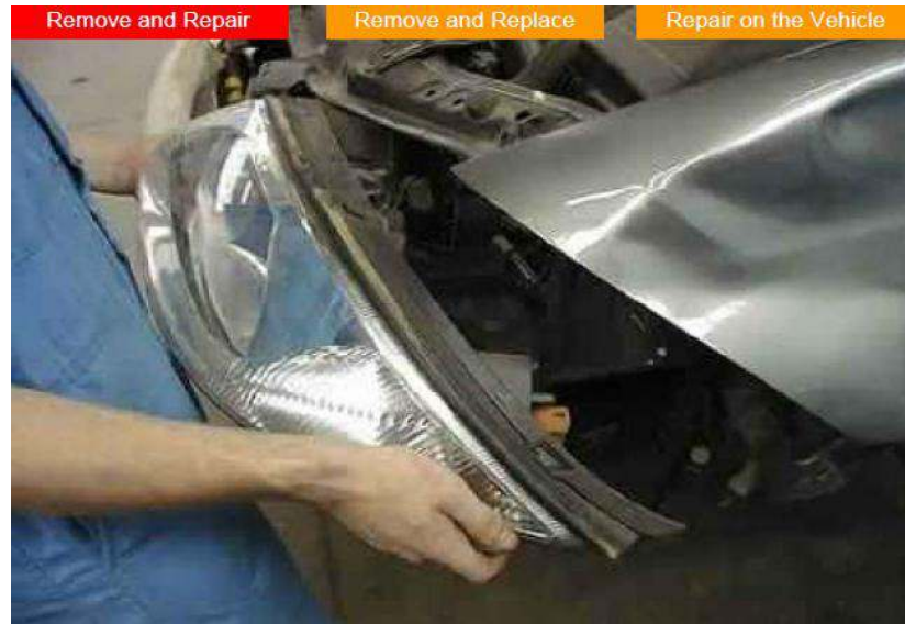
Gb.2.8. Pemasangan rangkaian lampu kepala
