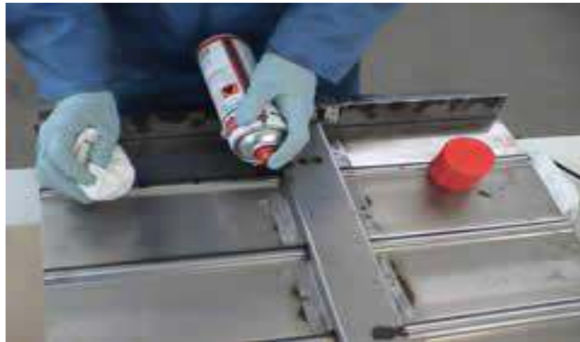
Gb.4.21. Pembersihan area pemasangan dengan semprotan pembersih/solvent
