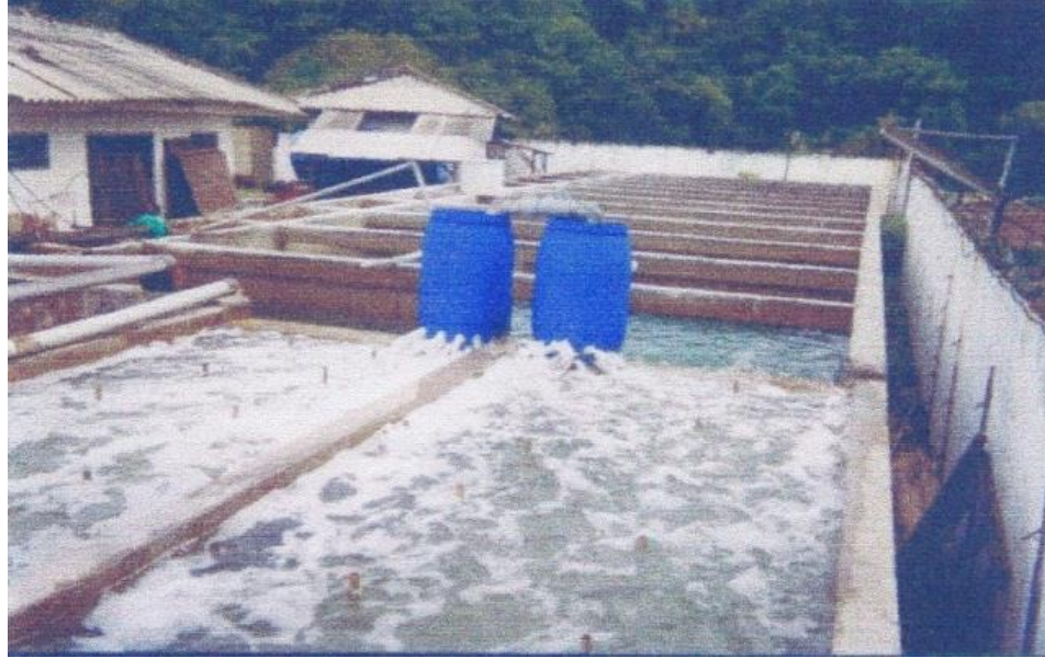
Gambar 14. Bak penyaringan dengan sistem gravitasi
