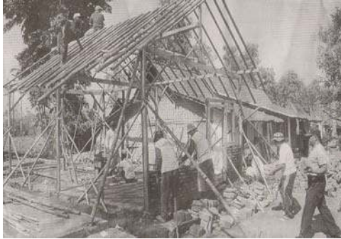
Gambar 3.9 : Beberapa pekerja sedang memperbaiki rumah yang roboh akibat badai
