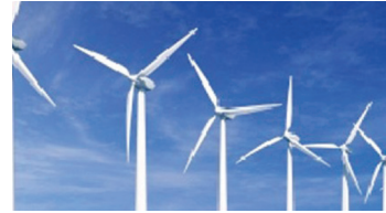
Sumber: ensiklopedia.com Gambar 5.15 Kincir angin ini mengubah energi kinetik angin untuk memutar generator listrik
