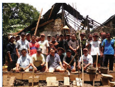
Sumber: Dokumen Kemdikbud Gambar 6.2 Warga bergotong royong memperbaiki rumah yang rusak
