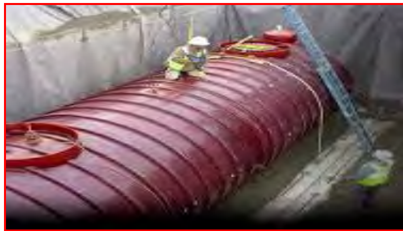
Gambar 19. Pemasangan tangki penyimpanan bensin dibawah tanah. ( www.bharattanksandvessel.com ).
