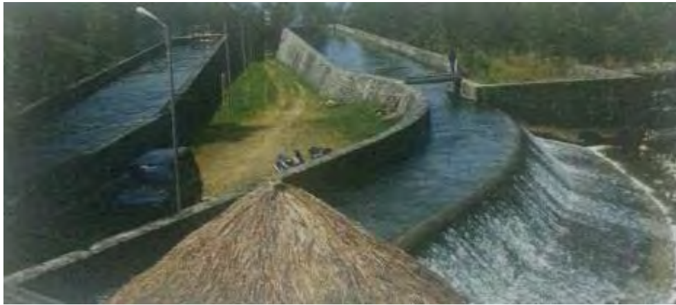
Gambar 6. Bendungan Walesi Papua
