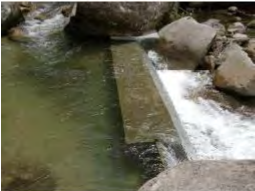
Gambar 5. Contoh Bendung Pengalihan / Dam
