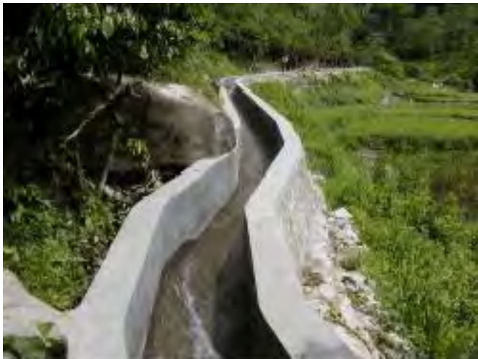
Gambar 7. Saluran Pembawa atau Headrace
