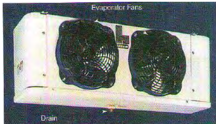
Gambar 2. 28 forced Evaporator untuk Walk-in Cooler
