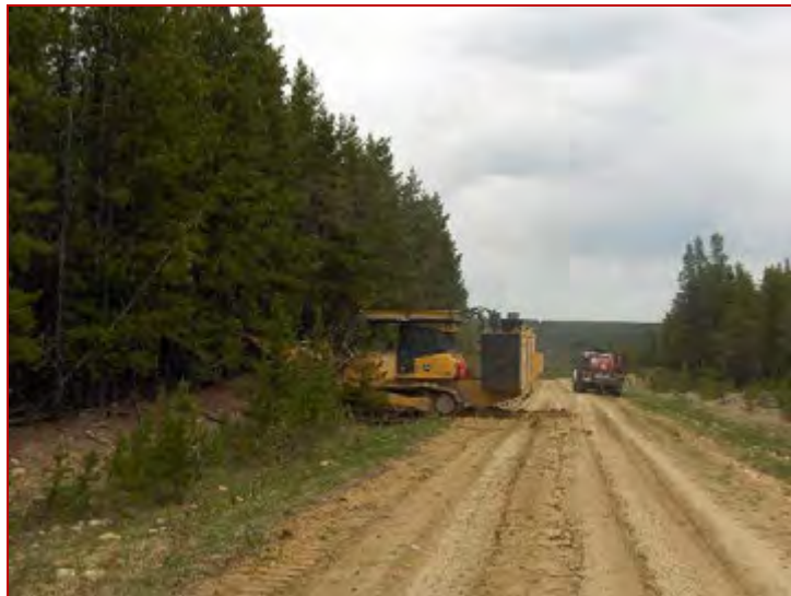
Gambar 2.2. Pembuatan jalan ke Lokasi Pemboran
