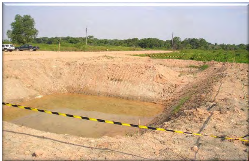
Gambar 2.4. Pembuatan Mud Pit
