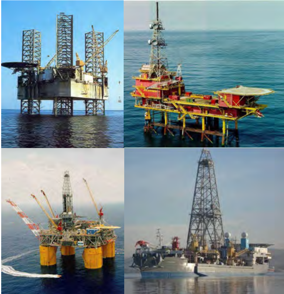
Gambar 4.4. Menara Bor Offshore
