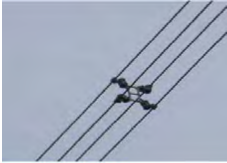
Gambar 4.34 Spacer untuk konduktor berkas 4 kawat (quadruple)
