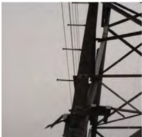
Gambar 4.19 Baut Panjat (step bolt)
