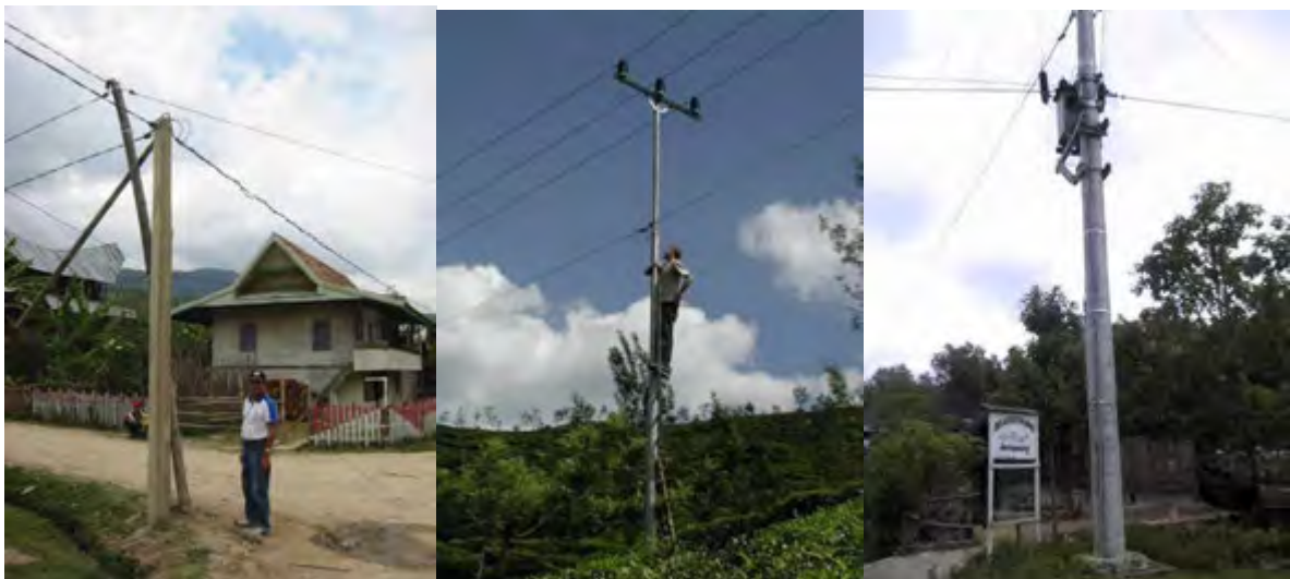
Gambar Material tiang listrik /poles ( kayu, besi, dan beton )
