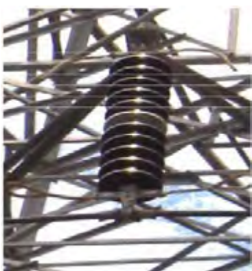
Gambar. Isolator renceng untuk tower suspension ("I" type)
