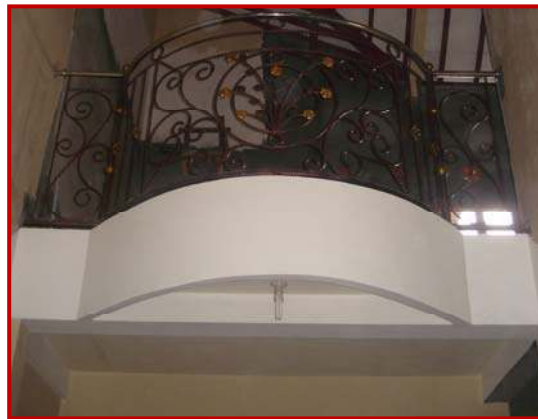
Gambar V-5, Hasil Plesteran dan Acian pada Bidang Sudut dan Bidang Lengkung
