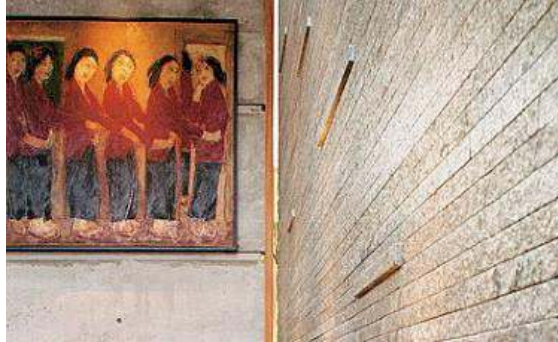
Gambar VI-10, Hasil Coating pada Dinding dengan Batu Tempel/Hias
