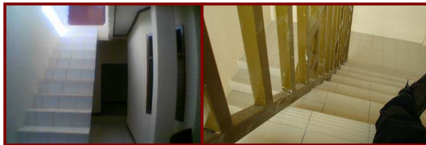
Gambar VI-5, Pemasangan Keramik Pada Konstruksi Tangga
