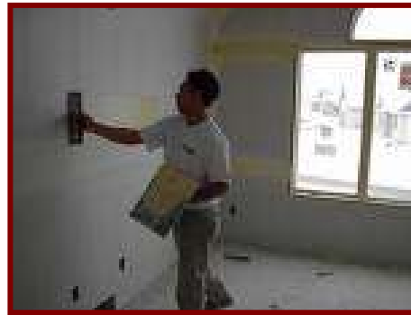
Gambar V-3, Pekerjaan Plamur (Under Coat)
