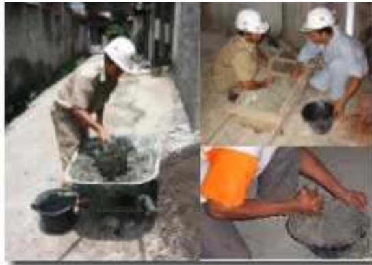
Gambar VIII-4, Persiapan Pembuatan Adukan Beton
