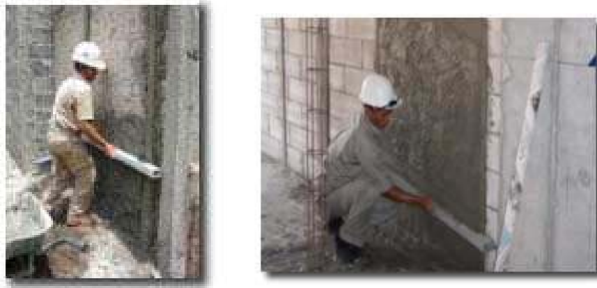
Gambar V-1, Pekerjaan Plesteran
