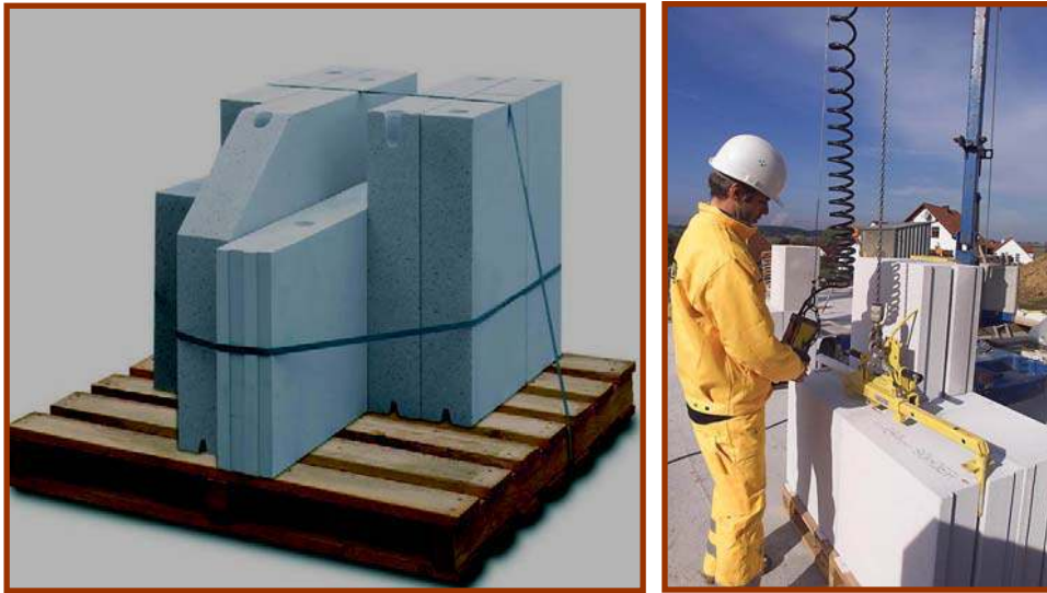
Gambar IV-7. Bata Hebel Dan Pengerjaan Bata Hebel.
