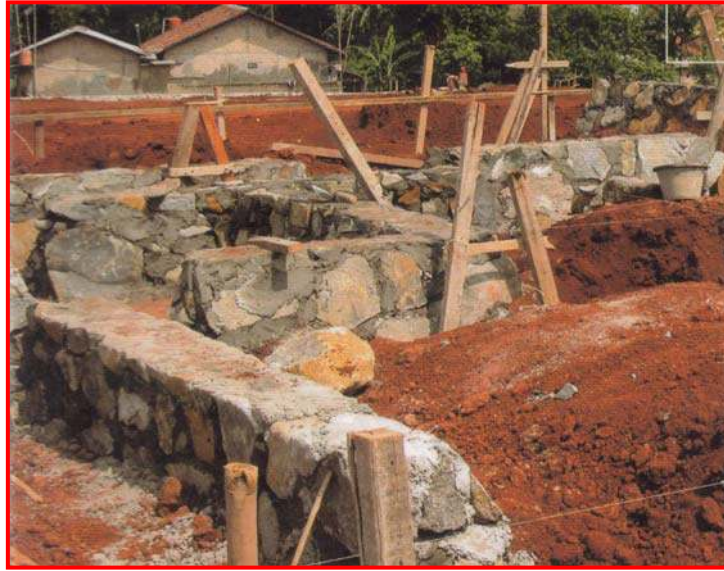
Gambar IV-5, Aplikasi Pondasi Batu Kali di Lapangan
