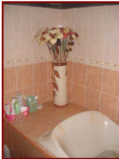
Gambar VI-11, Finishing dengan Pelapisan Keramik
