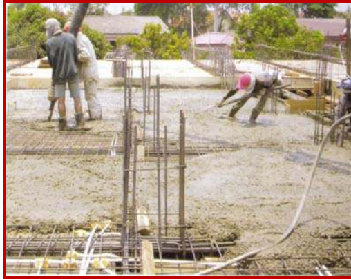
Gambar VIII-5, Pengecoran Beton
