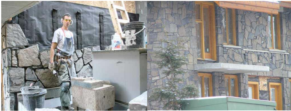
Gambar VI-9, Penutup Dinding dengan Batu Tempel/Hias
